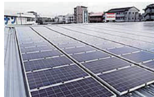
日产神奈川公司的一些经销店使用了太阳能电池板屋顶。太阳能电池板通过 PPS 系统向这些经销店供电。
